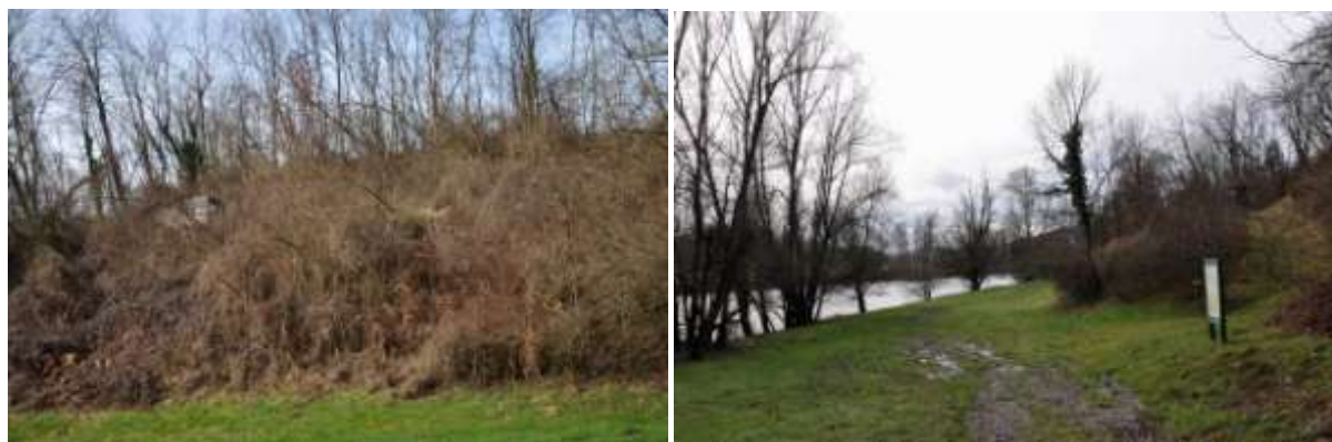
Foto 2-14: Nevzdrževana vstopno-izstopna mesta za čolnarje, zanemarjena infrastruktura
